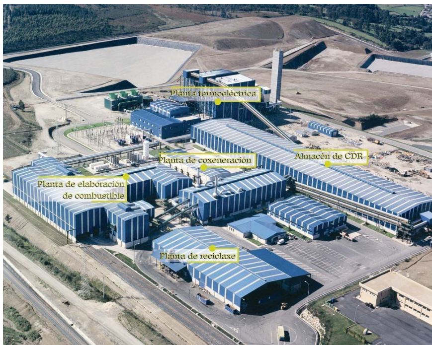
Vista de las plantas de cogeneración y termoeléctrica del Complejo Medioambiental de Cerceda. Fuente: Sogama
